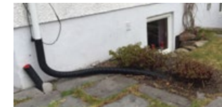
Frakoblet taknedløp - leder takvannet til et egnet sted
