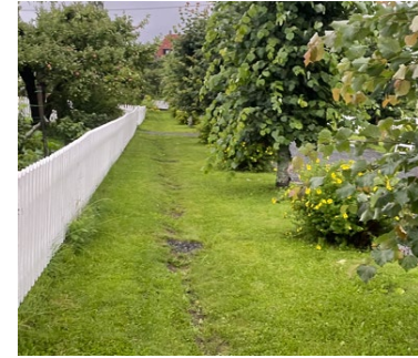
En grønn vannvei (vadi) - forsinker og leder overvann til et egnet sted.
