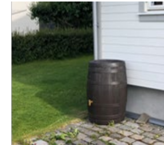
Regnvannstønner samler opp takvann som kan brukes til vanning i stedet for kranvann.
