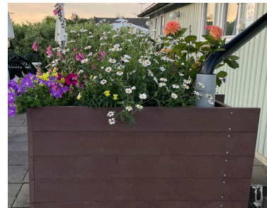
Et miniregnbed - kobles til taknedløp og bruker og forsinker avrenning av takvann.
