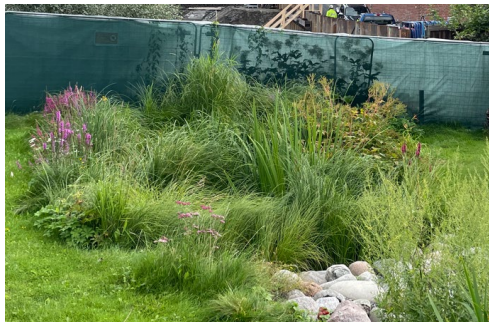
Regnbed - et forsenket blomsterbed i terrenget som samler regn- og overvann
